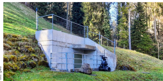
Brunnenstube der Quellwasserfassung in Goldingen
