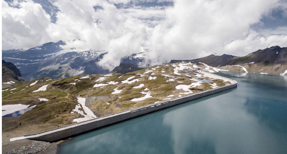
Der Mutsee (GL) ist mit 2473 m ü.M. das höchstgelegene Speicherbecken Europas. Pumpspeicherkraftwerke können überschüssige Solar- oder Windenergie speichern. Sie funktionieren als grosse Batterie und erhöhen die Versorgungssicherheit.
