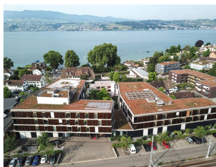
Erweiterung der Photovoltaikanlage auf dem Alterszentrum Lanzeln
