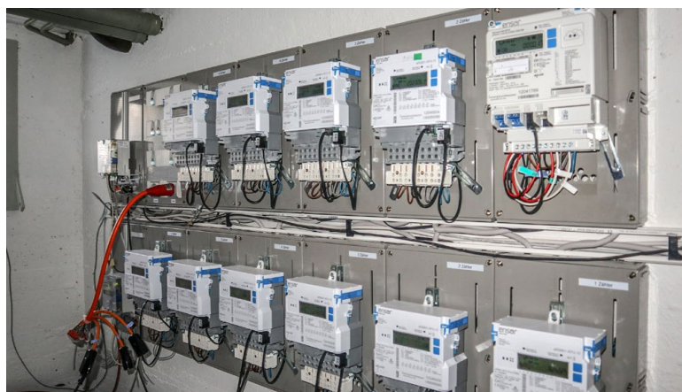
Die neuen Smartmeter werden in unserem Testlabor auf alle Funktionen getestet.
