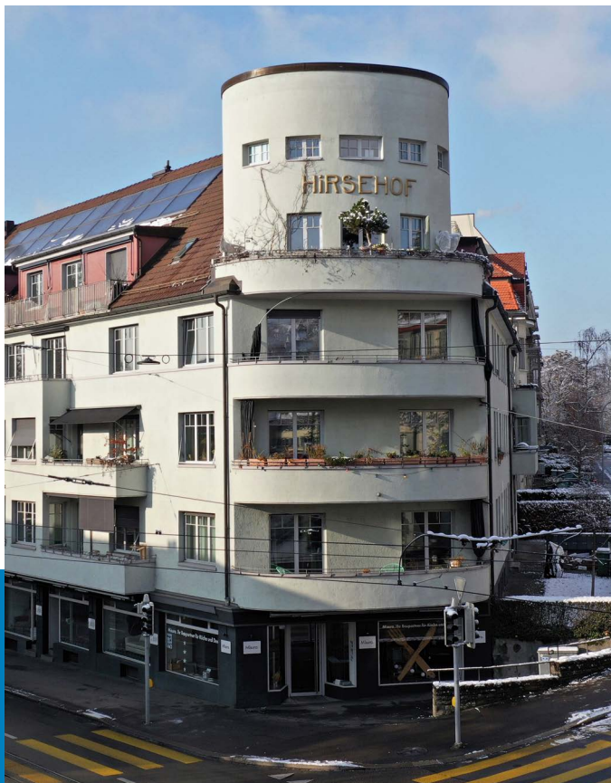
Mehrfamilienhaus, Zürich, Wohnzone
