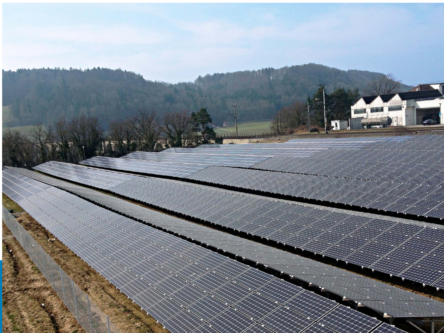
Freistehende Solaranlage, Eglisau, Industrie- und Gewerbezone
