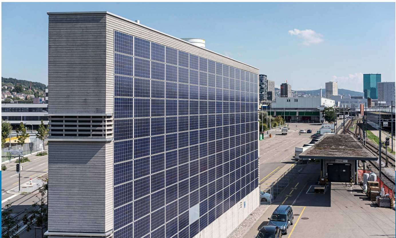
Stellwerk, Zürich, Industrie- und Gewerbezone
