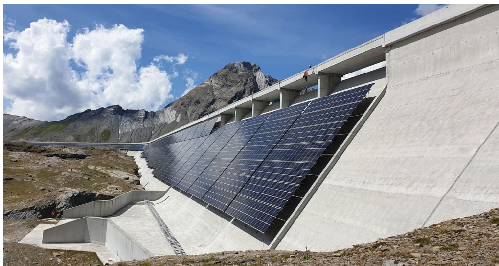
Die Mutsee-Staumauer im Glarnerland mit der grössten alpinen Solaranlage der Schweiz.
